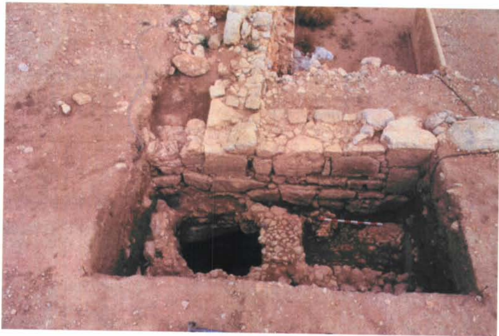
Fig.8. Vistes generals de l'excavació efectuada al cardo D (02-CR-CD-1000), situada a l'angle nord-oest del criptopòrtic. A sota s'observen el paviment del carrer i la sitja després de la seva excavació.
