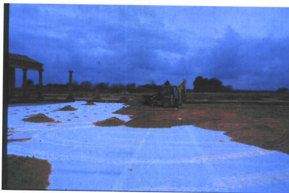
Fig. 5. Diferents fases del procés d'adeqüació de la plaça. A dalt, capa de geotextil que cobreix la capa inferior i, a sota, treballs de col.locació del paviment final.
