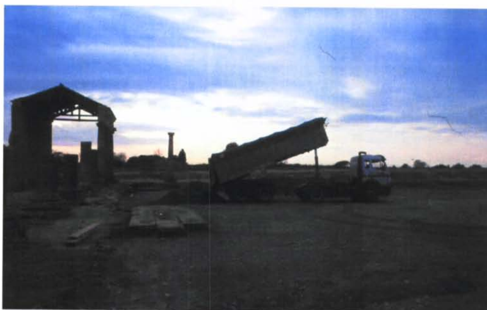
Fig. 4. A dalt, aspecte de la plaça una vegada finalitzada l'extracció de la gespa. A sota, reompliment de la primera capa amb graves drenants.
