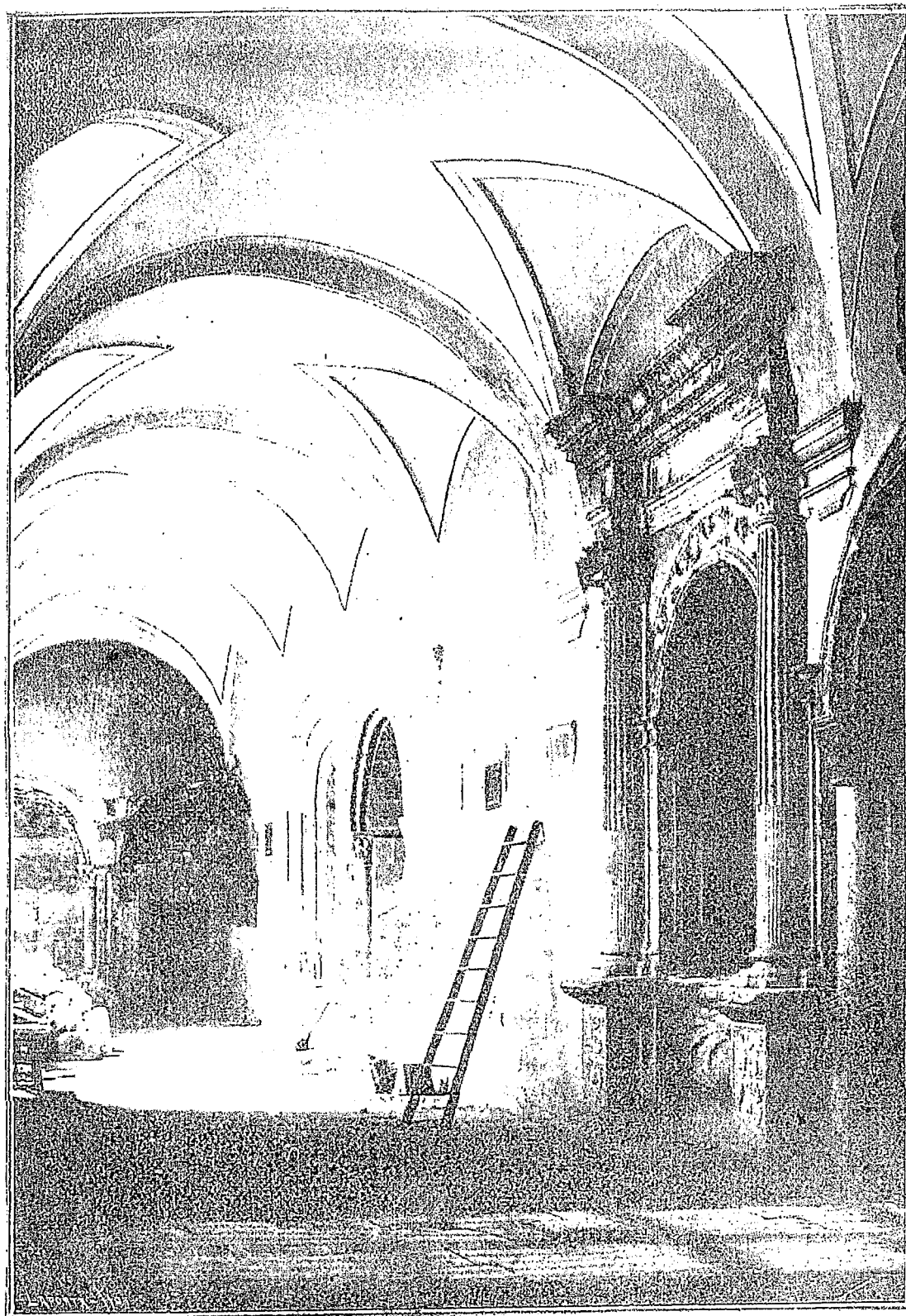
CLAUSTRO DE LA CATEDRAL VIEJA. Lado meridional durante los trabajos de limpieza, antes de su terminación
