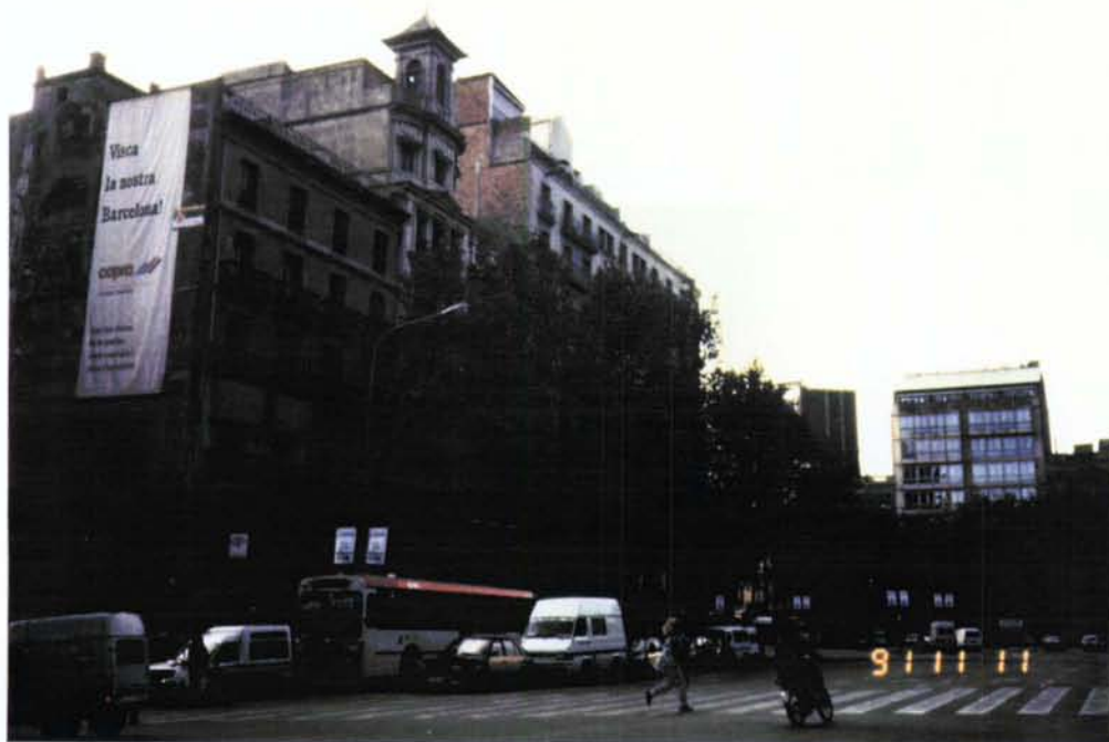
15) Façanes de la plaça Universitat
