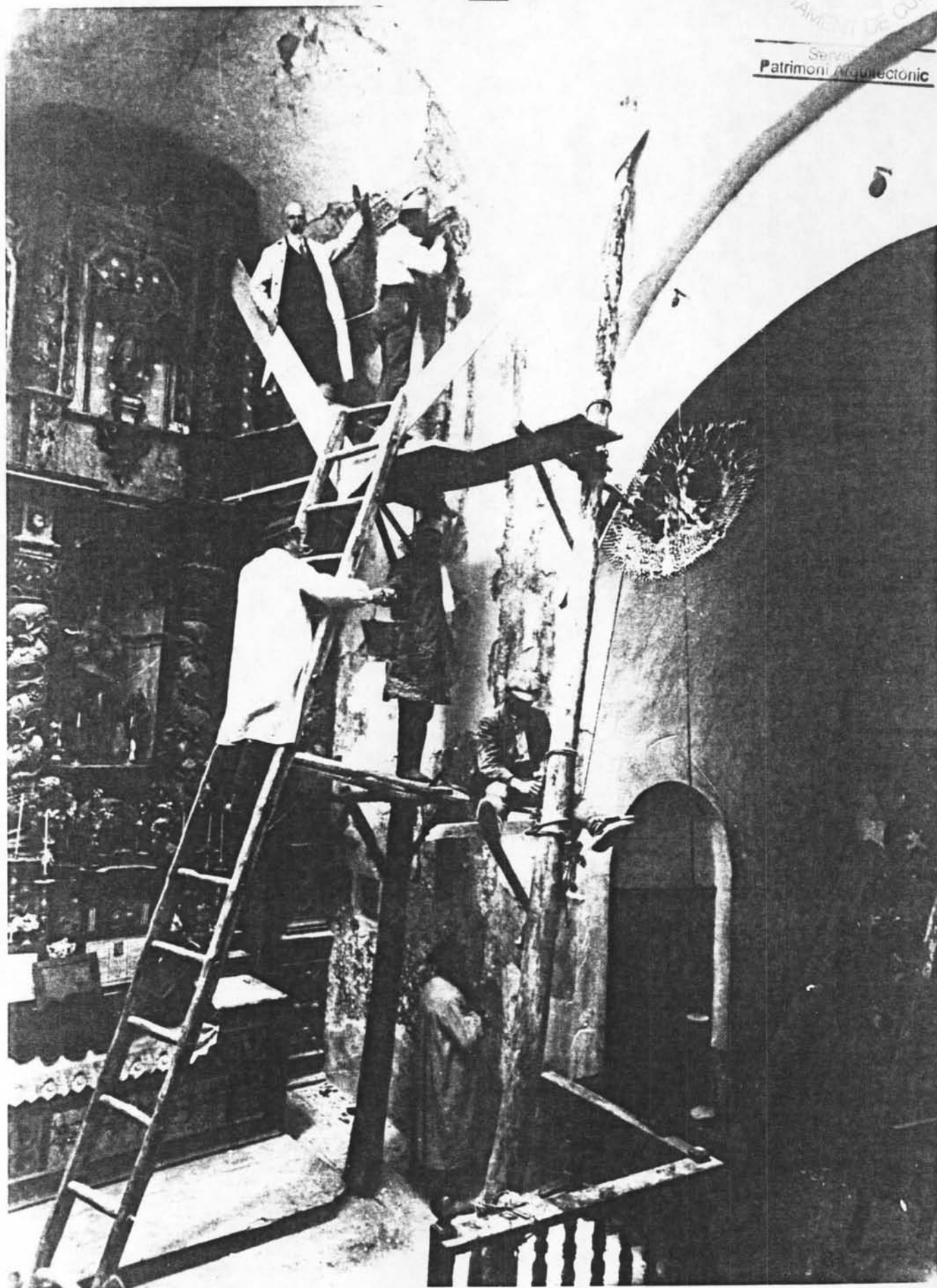
INTERIOR DE L'ESGLÉSIA DE SANT JOAN DE BOI DURANT L'ARRENCADA DE LES PINTURES (1.922) Clixé del Servei del Patrimoni Arquitectònic de la Diputació de Barcelona.
