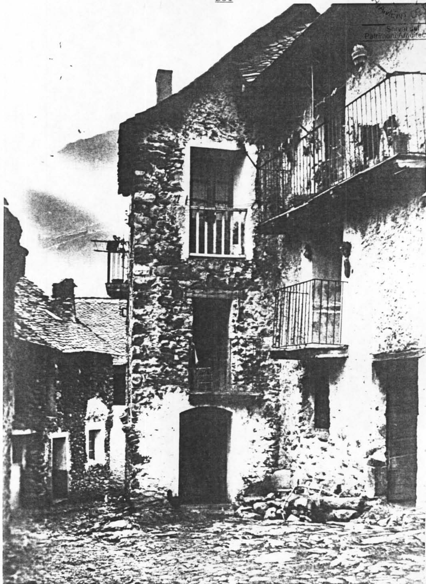
CASA DEL TARDANOR (parcialment a la dreta), actualment CASA DEL FERRER i CASA DEL SASTRE (al centre). Clixé (sense datar) del Servei del Patrimoni Arquitectònic de la Diputació de Barcelona
