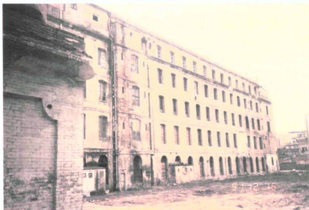
8. Façana Nord des de la Xemeneia
