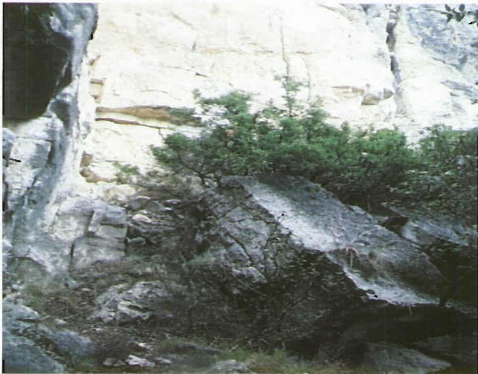
Figura 24 Bloc després per descalçament
