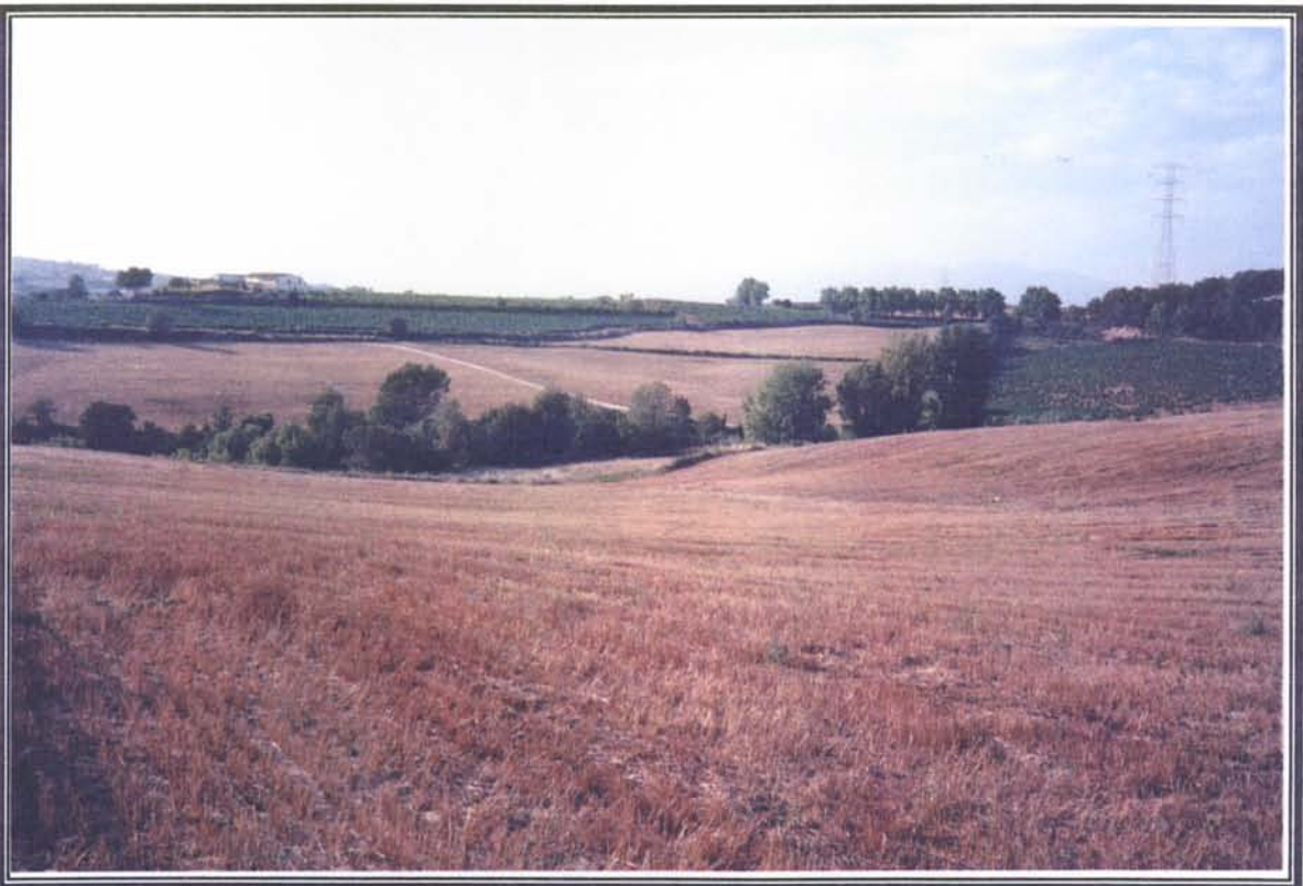
20. T.A.V. LLEIDA – MARTORELL. SUBTRAMO XI. Gelida Otra vista panorámica al área de acopios nº 4. Al fondo Can Miguel de les Planes
