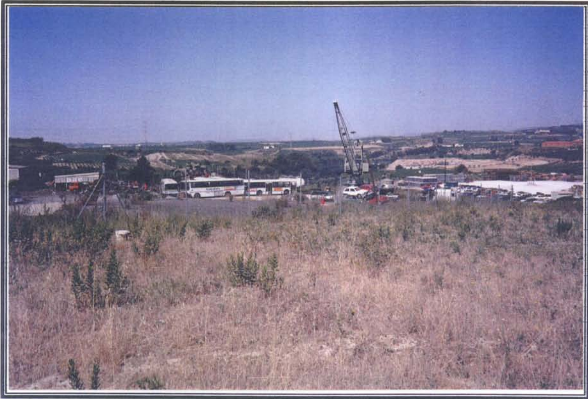
1. T.A.V. LLEIDA – MARTORELL. SUBTRAMO XI. Sant Sadurni d'Anoia Comienzo del trazado, panorámica en dirección Oeste al fondo las instalaciones de una chatarrería.
