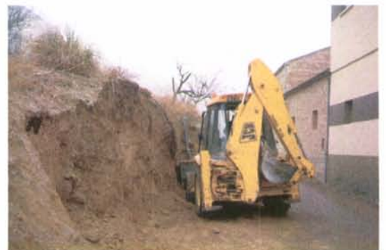
Detalls de la màquina retro-excavadora durant les tasques de desmuntatge del mur
