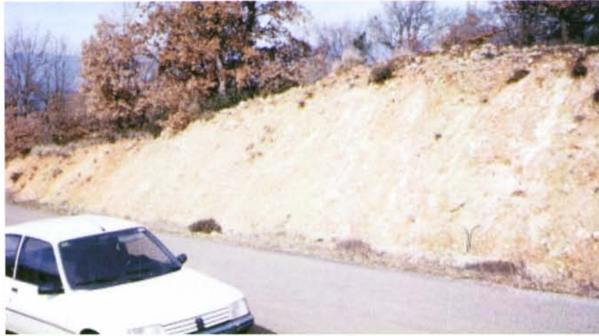
Col·luvions quaternaris (Qcs) en un talús de la carretera que dona accés a Covet.
