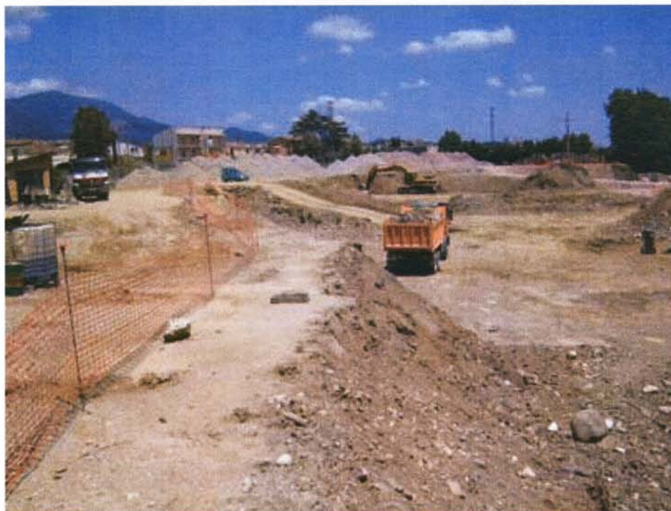
IMATGE 10. Rebaix de la zona nord de la plataforma superior.
