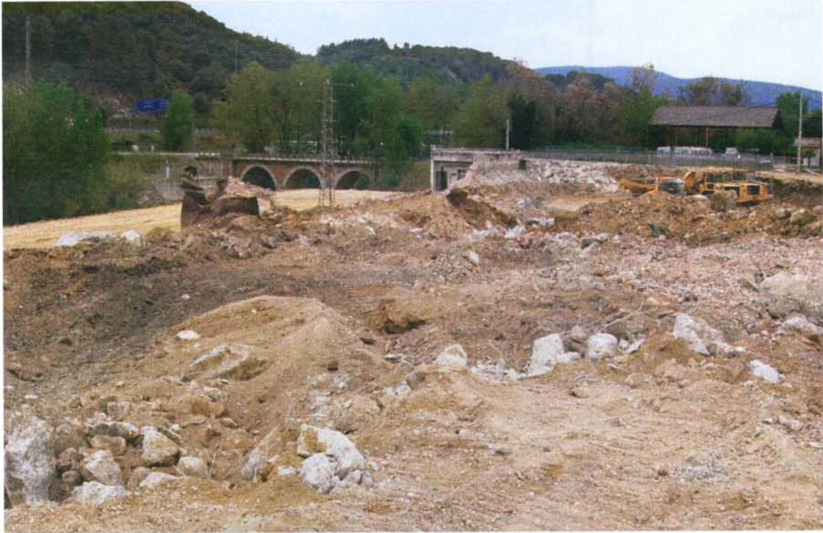
IMATGE 3. Conjunt des del nord. Pont, caldera, mur perimetral i estació transformadora.
