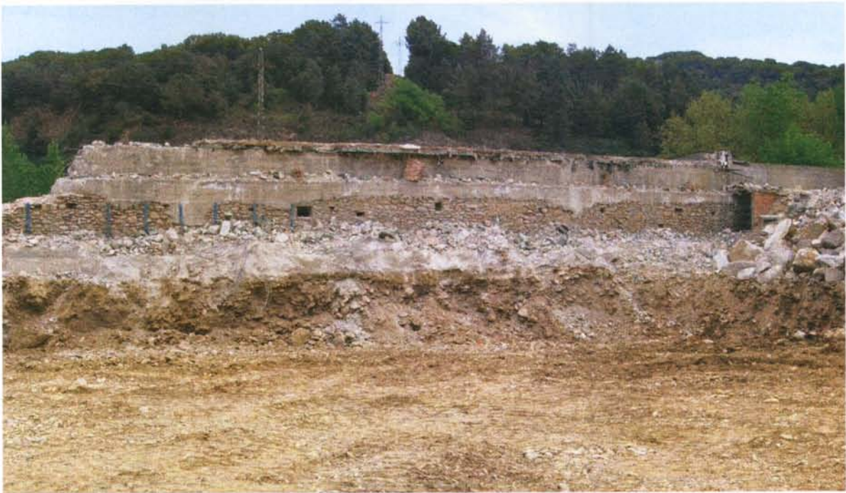
IMATGE 4. Interior del mur perimetral de 1919.
