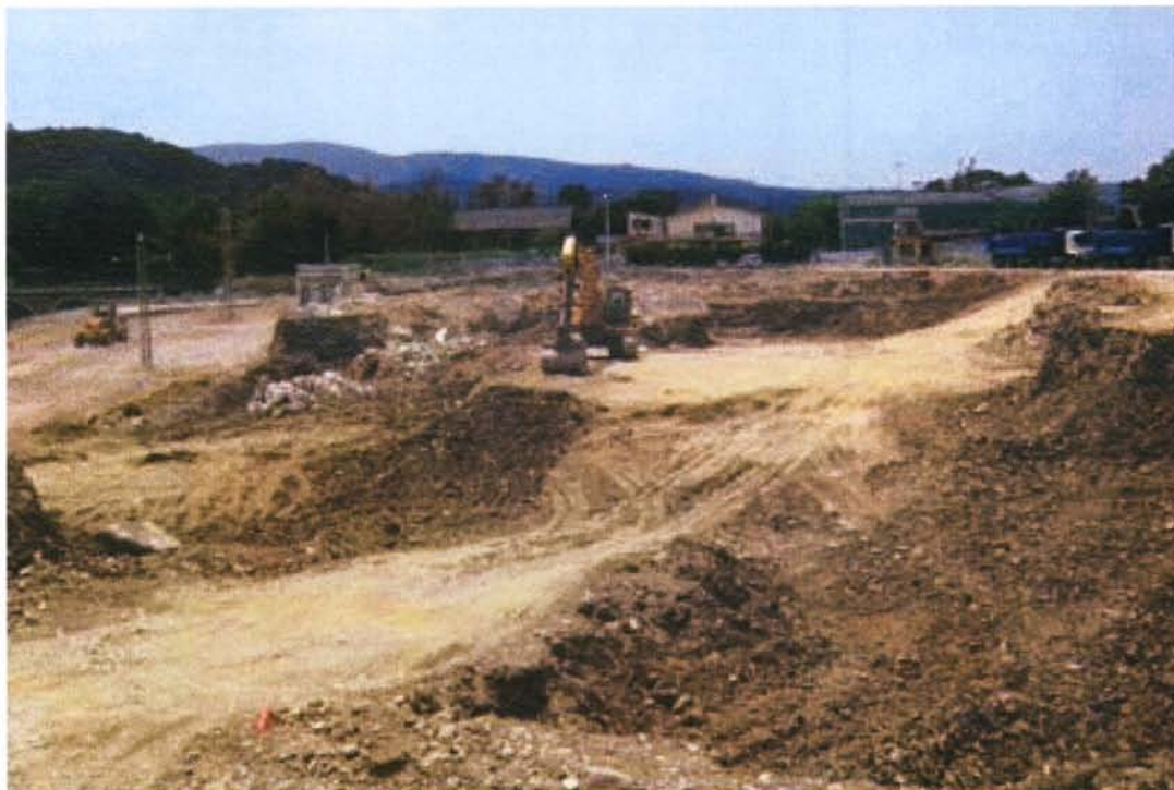
IMATGE 9. Rebaix de la zona central de la plataforma superior.
