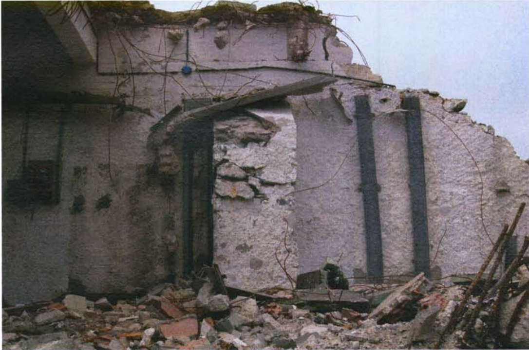
IMATGE 7. Contrafort a l'interior de l'estació transformadora.
