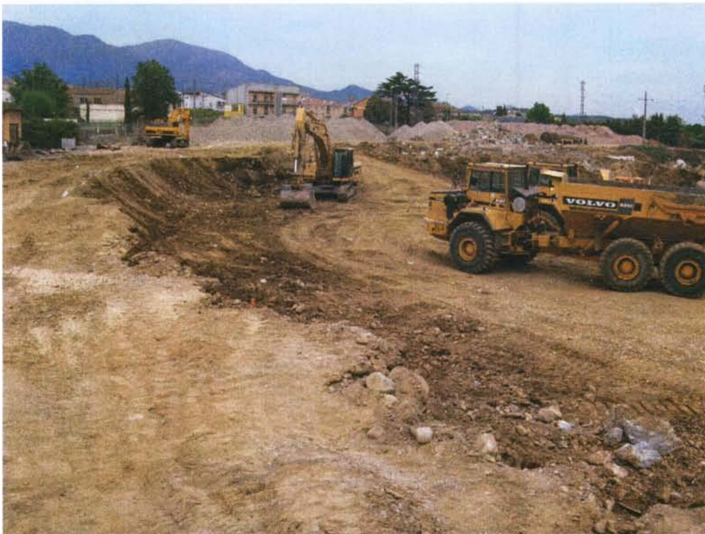
IMATGE 8. Rebaix de la zona sud de la plataforma superior.
