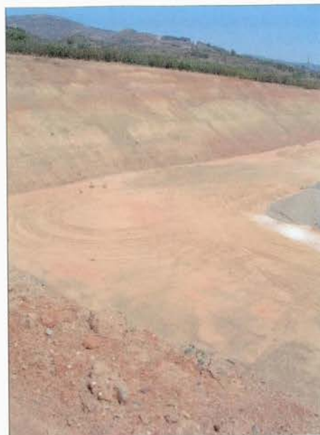
FOTO 8: Rebaix mecànic efectuat a la parcel·la adquirida per BTI.
