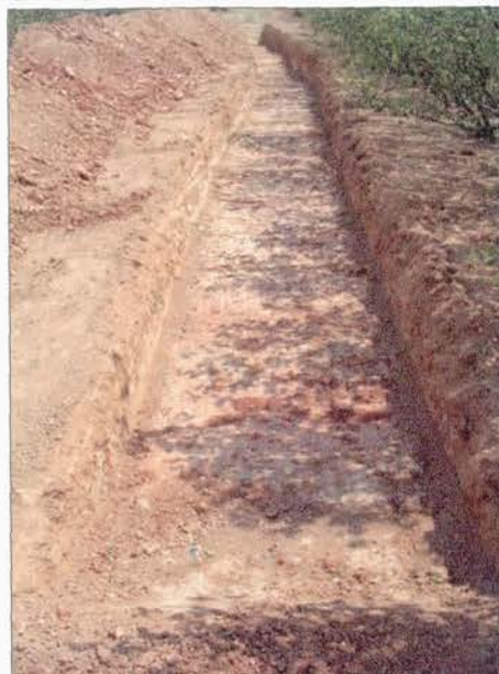
FOTO 14: Vista de la rasa 300 des del sud-oest.
