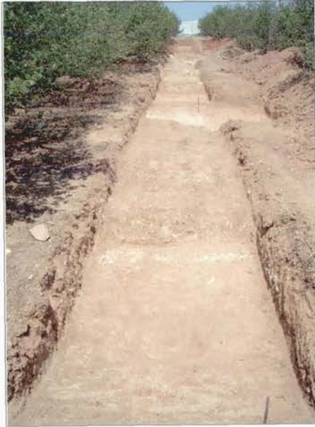
FOTO 31: Vista general de la rasa 1200 des del sud-oest
