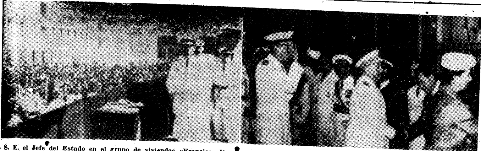
1. S. E. el Jefe del Estado en el grupo de viviendas «Francisco Franco», en la zona de «Los Vadillos» (Burgos), para hacer entrega de las llaves a sus beneficiarios. — 2. El Generalísimo es saludado por las autoridades de San Sebastián a su llegada al Palacio de Ayeite.
