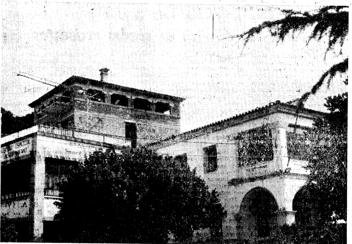
Aspecto de las obras de ampliación de la mutualidad.
