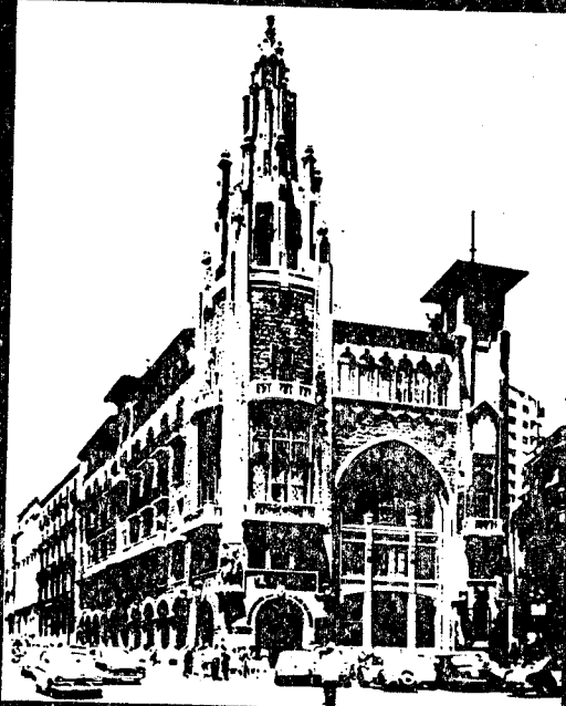
oficinas centrales: Via Layetana 56-62 Barcelona 3
