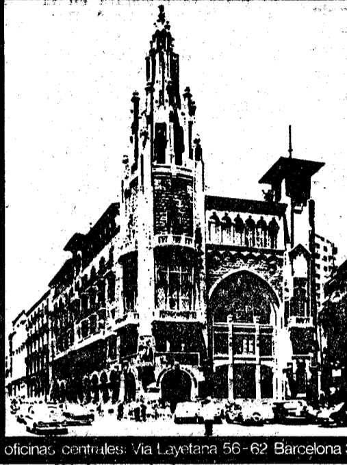
oficinas centrales: Via Layetana 56-62 Barcelona 3
