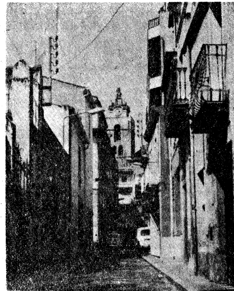
Santa Coloma espera expectante el inicio de las obras de su nuevo Hospital-Geriátrico, al que irá a parar la casi totalidad de la herencia de los hermanos Sureda, dejada a la ciudad con fines asistenciales.
