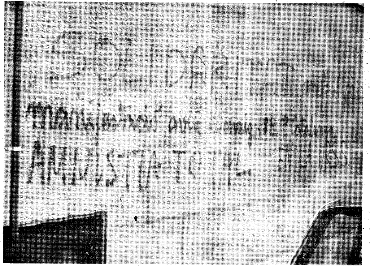
Las pintadas sobre piedra sólo se solucionan con el repicado de aquélla. (Foto Pablito)
