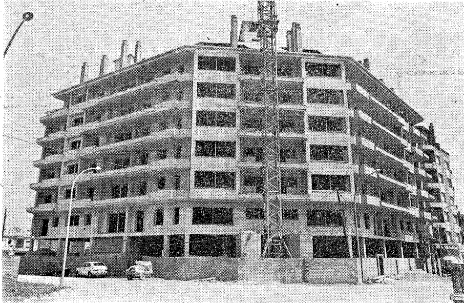
Edificio del Passeig d'Olot, núms. 328-330, en construcción.
