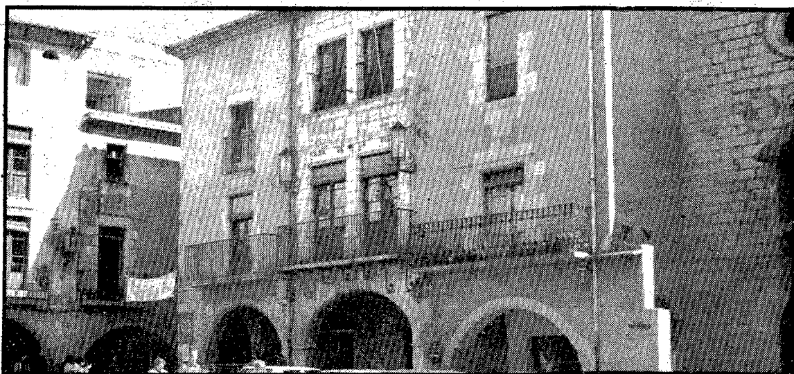
La Casa de la Vila de Torroella de Montgrí.
