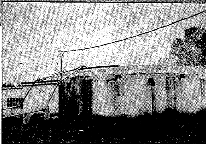
Muchos colomenses han decidido abastecerse por unos días del agua de la fuente de Sant Salvador uniéndose a los que la consumen habitualmente. En la foto inferior, instalaciones de suministro de agua. (Foto CARLOS SANS).
