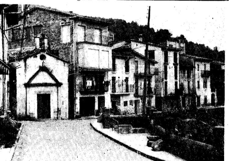
Obres en el carrer de Sant Sebastià. Una nova fisonomia amb el caràcter de sempre.
