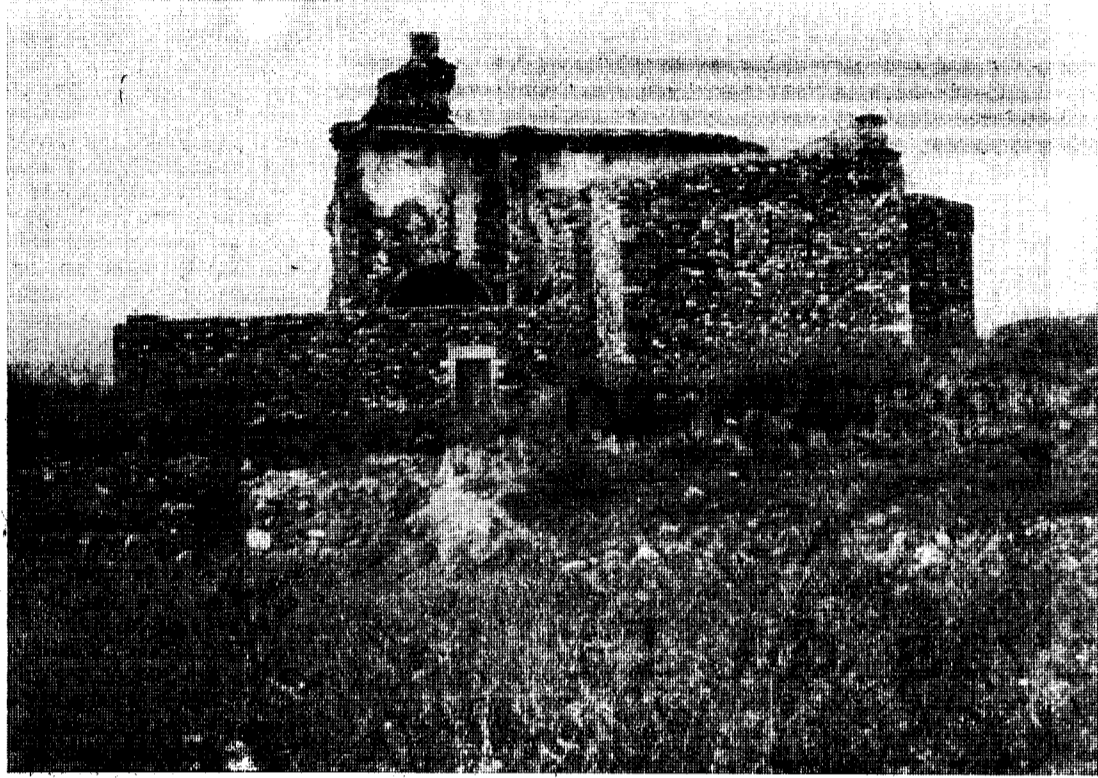
Una vista de lo que fue iglesia de Santa María, una de las construcciones más antiguas de su tipo. A su alrededor, mucha maleza, que hace casi imposible llegar hasta ella.
