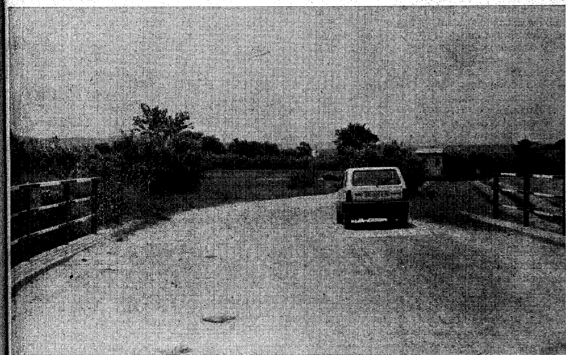
Durante años, la carretera de Perelada a Mollet ha visto su pavimento súbitamente cortado por espacio de 150 metros. Después continuaba como si tal cosa. El motivo: un vecino no quería que cruzasen por sus campos. Ahora, la Diputación expropia el trozo de finca requerido.
