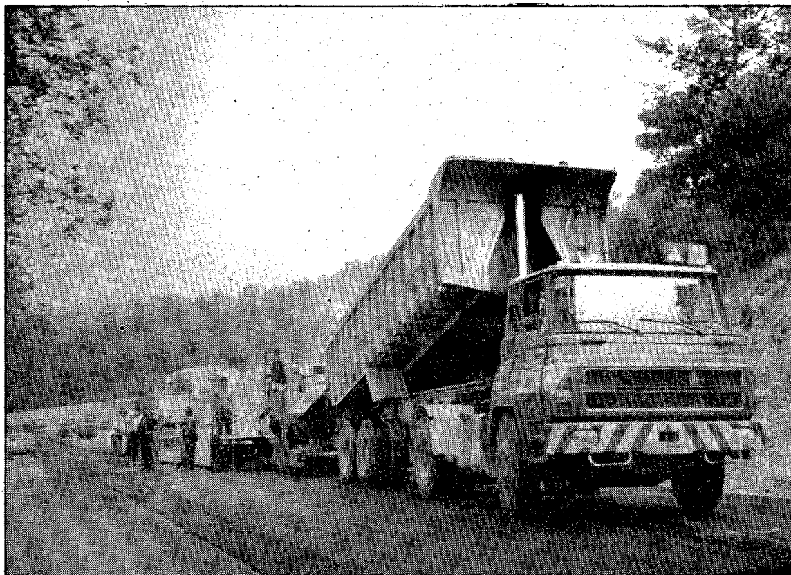
En la C-150 se asfalta desde la salida de Banyoles hasta la Pujada de Can Ordís. (Foto JOSEPHUS).
