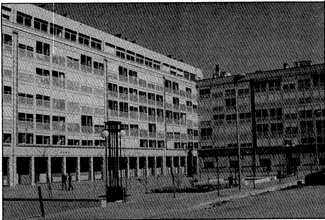
Les façanes estan tractades amb elements d'alumini.
