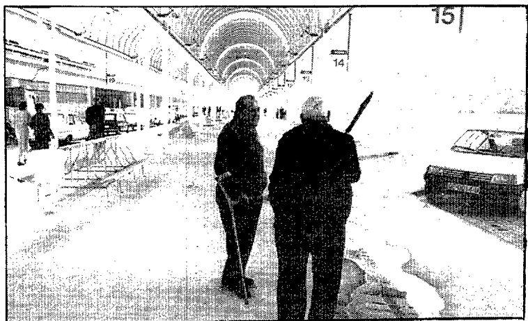
Antes de los dos años, goteras. (Foto DANI DUCH).
