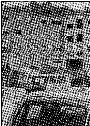
Los vecinos de Vila-roja, molestos por las anomalías de sus viviendas.
