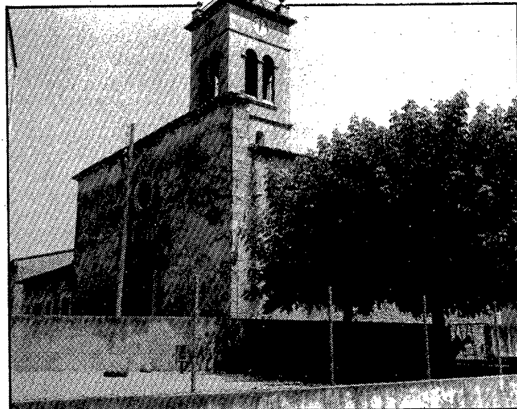
Bescanó ha començat les obres d'adequació de l'església de Sant Llorenç i del seu entorn. (Foto JOAN SEGUR).
