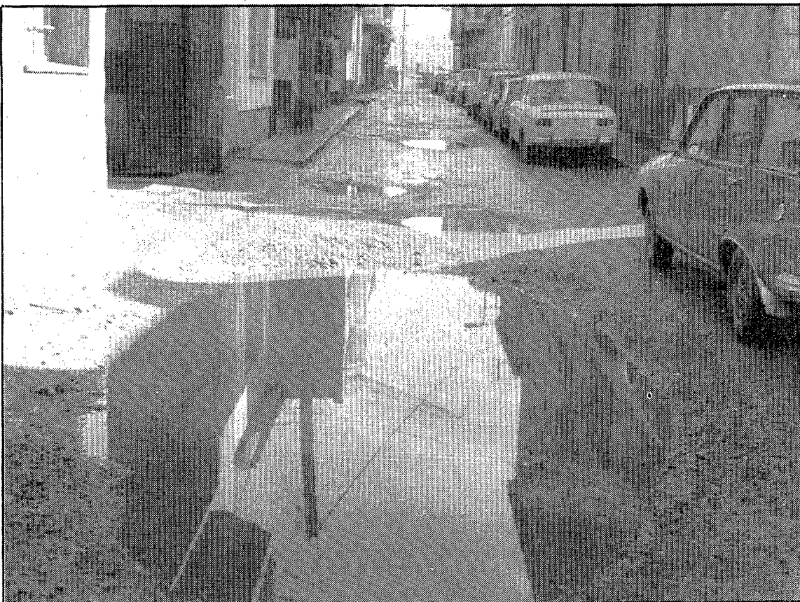
Varias calles del barrio se encuentran todavía sin asfaltar.
