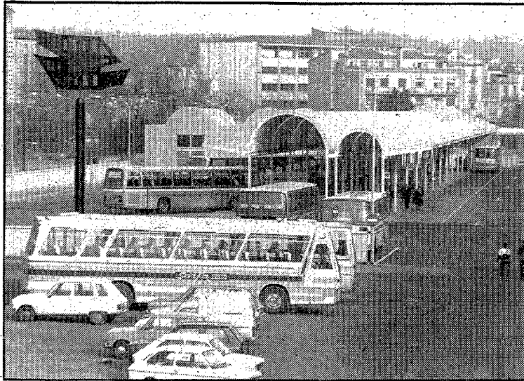
Es necesario ampliar la superficie de aparcamiento de los autobuses. (Foto D. DUCH).
