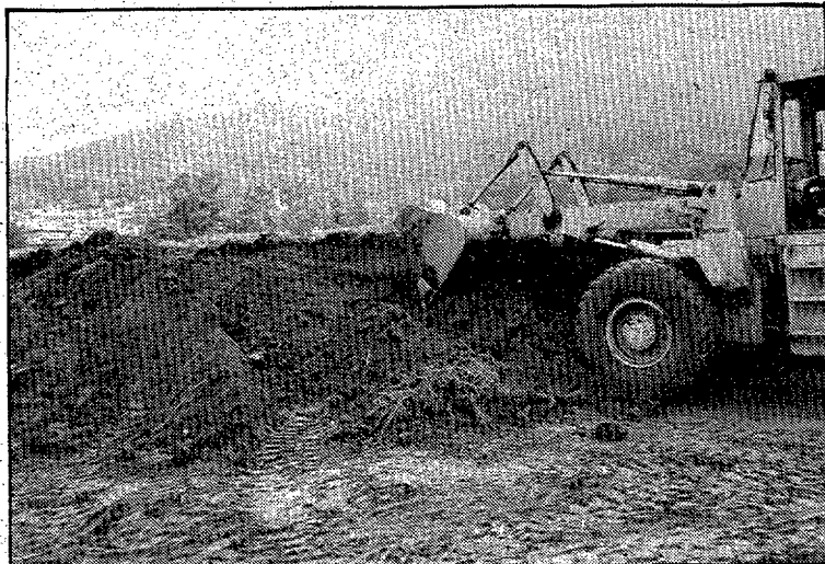
Els voltants de la carretera Xanacs-Murrià s'estan rehabilitant. (Foto JULI).
