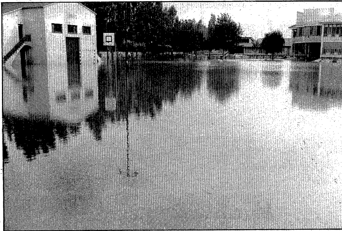
Les escoles de Castelló d'Empúries varen resultar molt afectades per les pluges de fa dues setmanes. (Foto PUÉRTOLAS).
