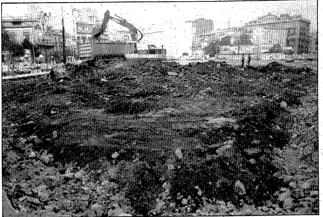
Instantània de la plaça durant les obres de demolició. (Foto: DANI DUCH)
