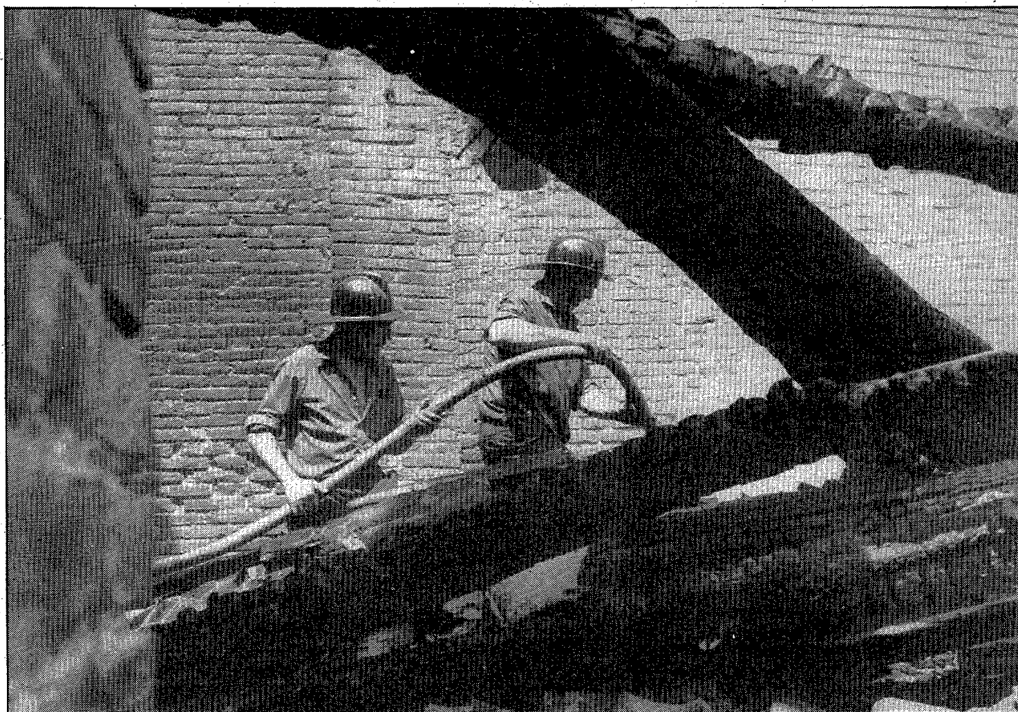
L'estructura de l'edifici pot jugar una mala passada. (Foto: SANS)
