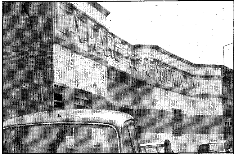
Els treballadors acomiadats de la fàbrica de Farga Casanova a Ripoll podran tornar a treballar-hi. (Foto R.R.).
