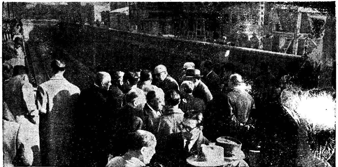
Ayer, el alcalde de Barcelona, acompañado de varios tenientes de alcalde y concejales, el jefe de la V Zona de la RENFE y otros técnicos del Ayuntamiento, presidió la inauguración oficial de las obras para cubrir la zanja de la calle de Aragón, que estarán terminadas dentro de este mismo año.
