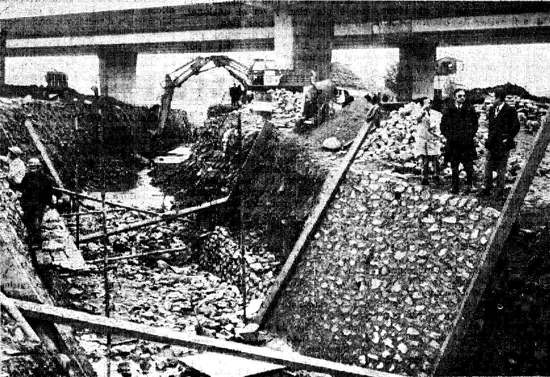
En visita a las obras de encauzamiento de los ríos de Gerona capital, en 1972.
