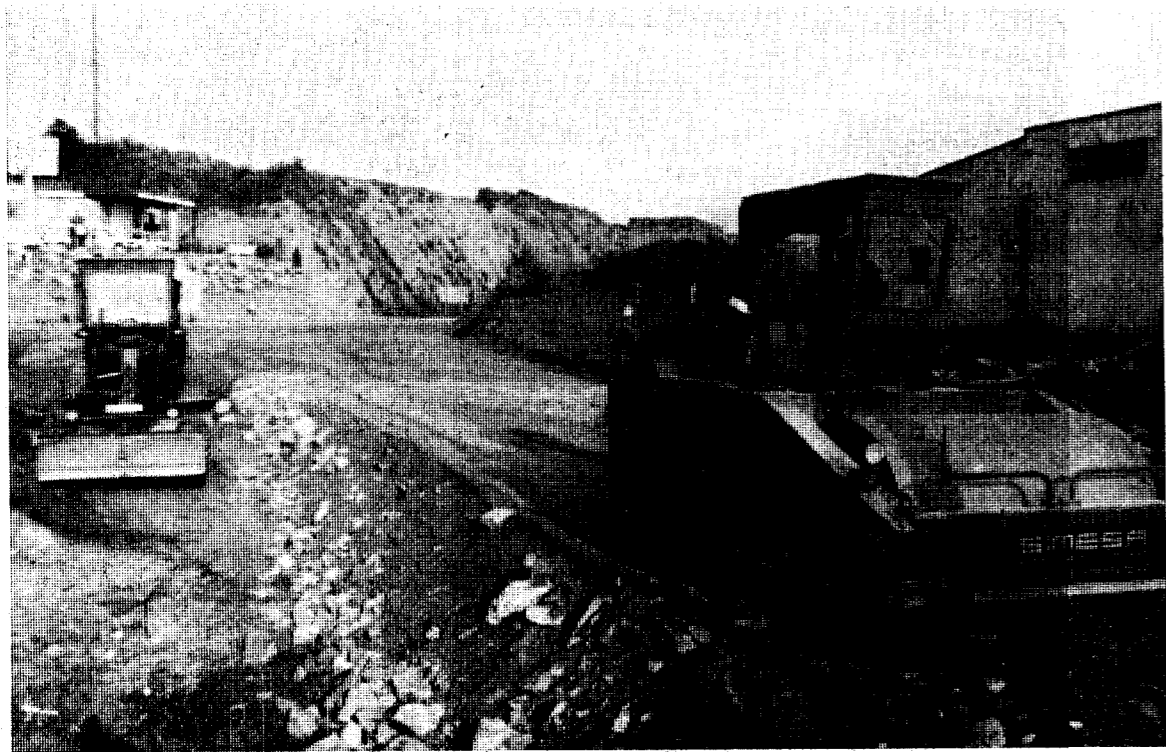
Era serio el peligro (los accidentes lo han demostrado) muy cerca del núcleo urbano de Blanes. Y el Ayuntamiento de la localidad costabravense ha decidido acabar con él. Así, se han iniciado las obras del paso inferior en el cruce de la carretera de nuevo acceso a la Costa por esa población. En la fotografía de Robert, las máquinas, en plena acción.
