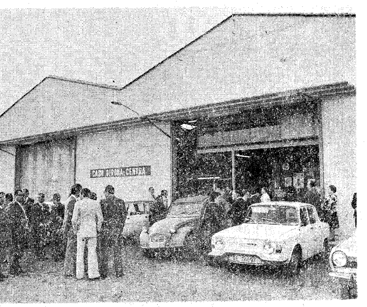
Parcial aspecto exterior del «CASH GIRONA», situado en calle Escuelas, s/n., del barrio de El Perelló de Vilablareix, al pie del camino de Gerona a Santa Coloma de Farnés.
