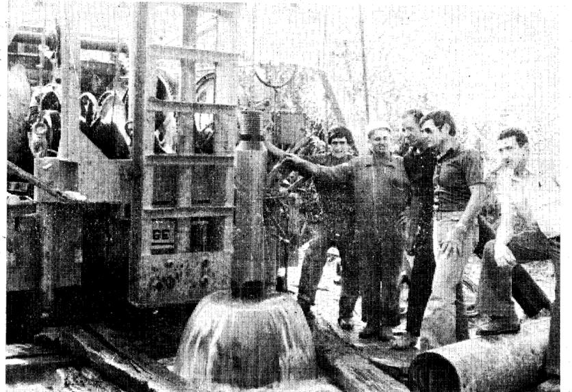
Por encargo del Ayuntamiento de Sant Joan de Mollet, una empresa de perforaciones procedió a la apertura de un pozo con el propósito de resolver el problema del abastecimiento de agua potable de la localidad ampurdanesa. Se fijó el punto exac-
