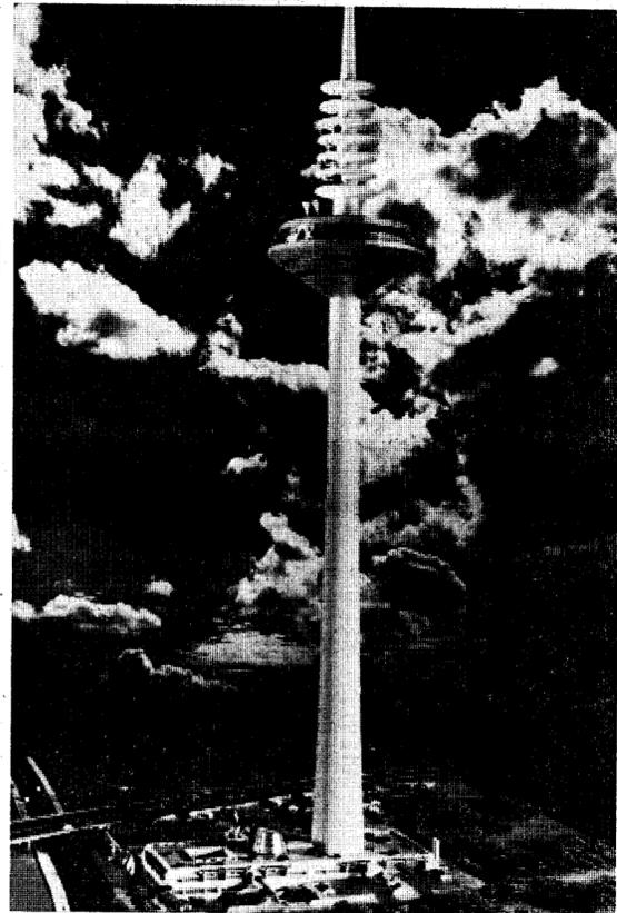
Esta es la maqueta de la torre de televisión que va a ser construida en Francfort del Main (Alemania Federal) y que será, con sus 331 metros desde la base hasta el extremo superior de la antena, la más alta de Europa Occidental. La plataforma giratoria albergará un restaurante con capacidad para 220 comensales y estará ubicada a 221 metros de altura. La torre será inaugurada, probablemente, en 1978.
