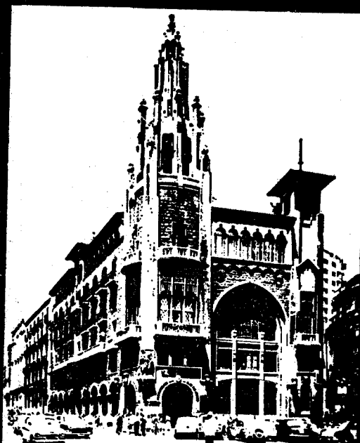
oficinas centrales: Via Layetana 56-62 Barcelona 3
