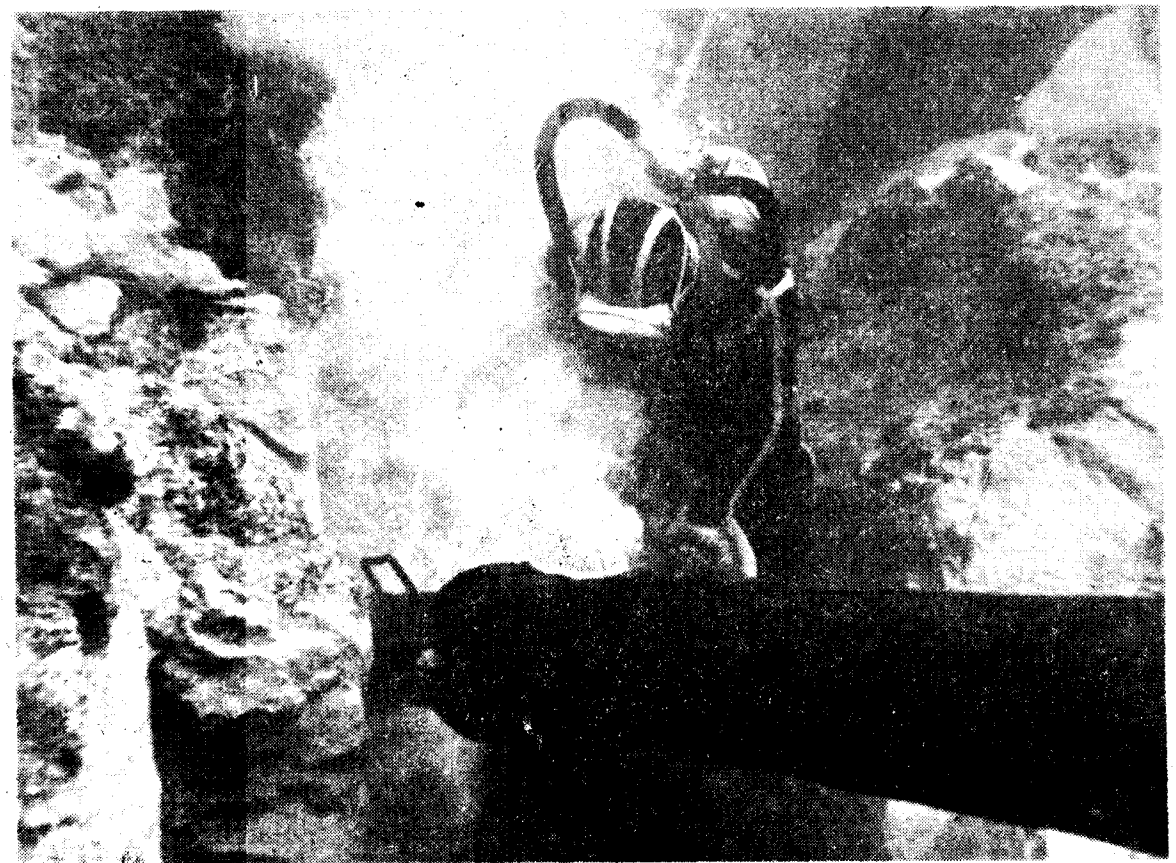
Trabajos de montaje del emisario submarino en fondo de roca. En primer plano, la tubería de aspiración de los equipos de dragado.
