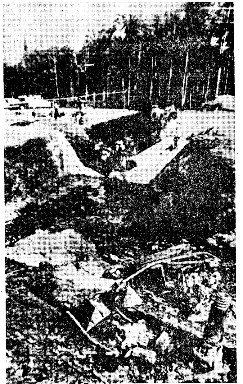
Trabajadores del oleoducto de Alaska inspeccionan una sección del mismo en una zona próxima a la localidad de Fairbanks, donde se produjo la explosión en la que una persona resultó muerta y otras seis con quemaduras diversas.
