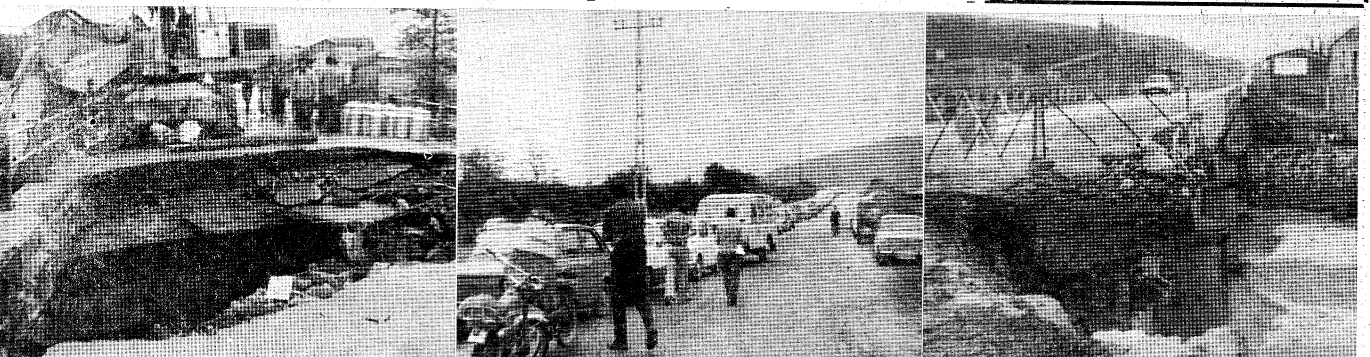
Continuamos hoy ofreciendo a nuestros lectores información gráfica de los daños causados por las inundaciones sufridas en nuestra provincia, por las intensas lluvias caídas en los últimos días. En esta ocasión, la cámara de Sans se ha detenido, de izquierda a derecha, en el puente de Ridaura, del que ofrecemos una imagen de los desperfectos y la cola de coches formada antes de llegar al mismo. A la derecha, el enorme socavón producido por la riada en el puente de Sant Jaume de Llierca.
