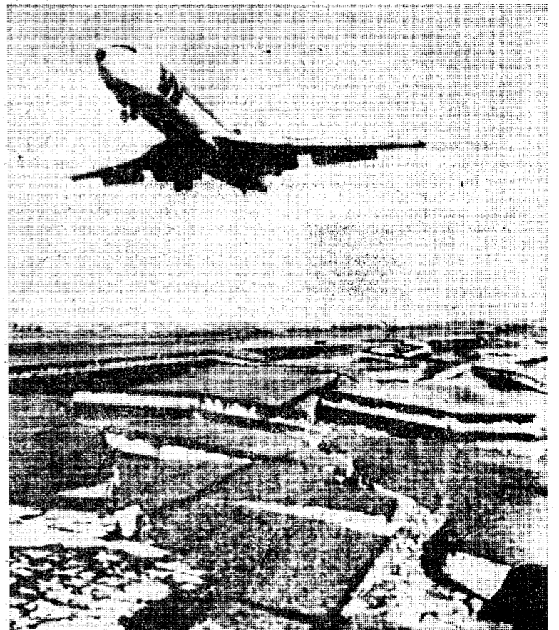
Un avión comercial despegó del aeropuerto internacional Sky Harbor, de Phoenix (Arizona, Estados Unidos), a pesar de los graves desperfectos (en primer término) que ocasionó en el pavimento de la pista principal el desbordamiento del río Salt. Las obras de reparación costarán unos trescientos millones de pesetas.
