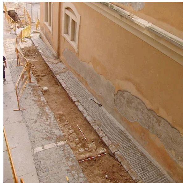
Figura 11. Vista general de la rasa oberta al tram inferior del carrer de Bernat de Fonollar (juliol de 2013), amb la localització del mur ibèric
