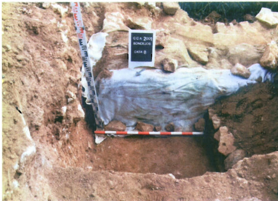
FOTO 10. Foto final cala 8 vista des del NW. Al fons de la imatge apareix el mur de tancament del conjunt protegit amb geotèxtil. A la dreta un petit muret de contenció per reduir el volum de la cala.
