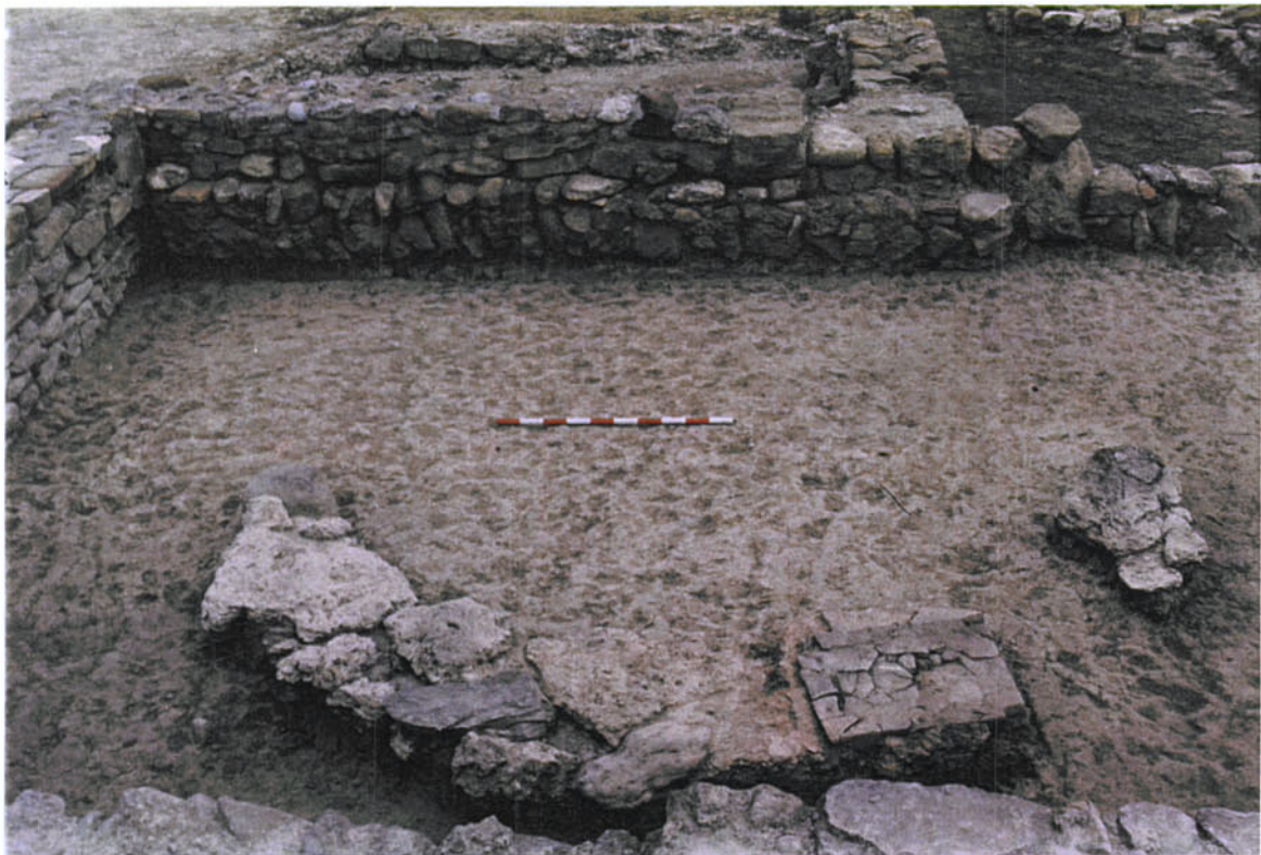
Detall de la motllura o kyma reversa localitzada format part de l'enderroc de la fase baiximperial. A sota, treballs d'adequació a l'ala oest de la vil.la.
