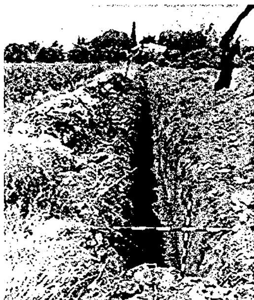
Figura 21. Vista general de la rasa 33. Part est de la zona de sondeig.
