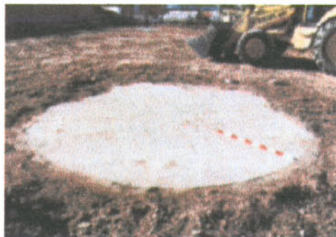
Resto del depósito de agua moderno.
