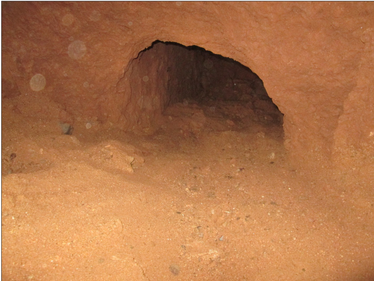
Figura 9. Galeria ensorrada del refugi del carrer de Burgos (Foto: SABCN).
